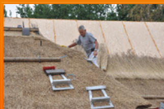
SlimFix XT Riet voor rietdaken (nieuwbouw/renovatie)
