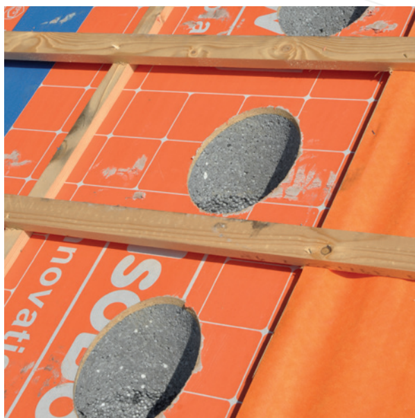
Fabrieksmatig aangebrachte, projectspecifieke doorvoer sparingen.
