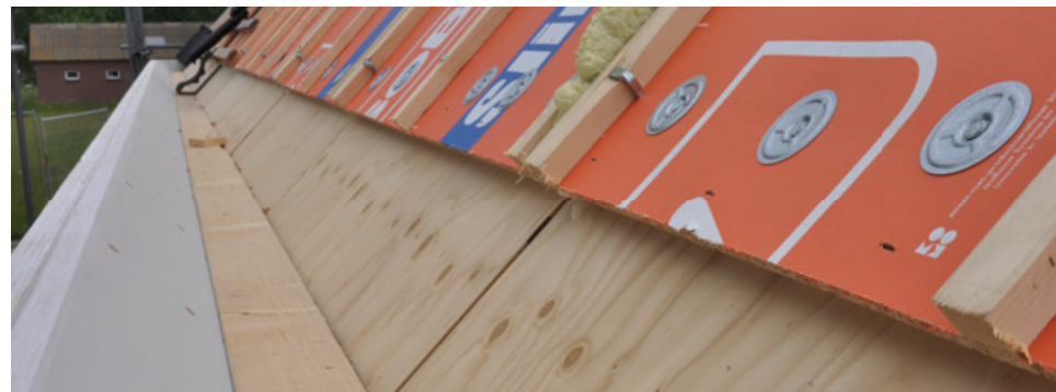
Meerdere maatwerkopties zoals bijvoorbeeld voor eenvoudige realisatie van slanke kopgevel- en gootverstekken en een boeiboordverjonging
