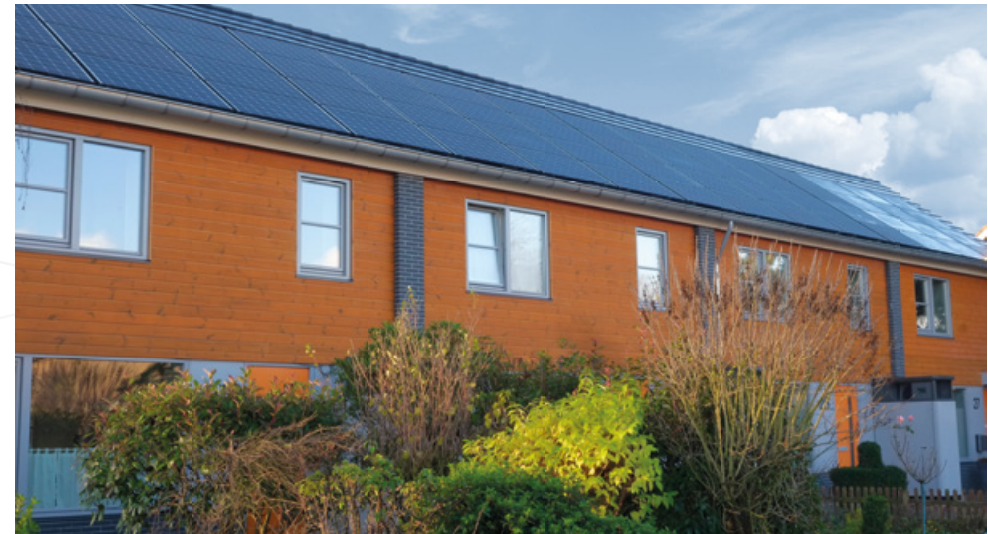
Waterdicht, goed ventilerend en vliegvuurbestendig PV-indak
