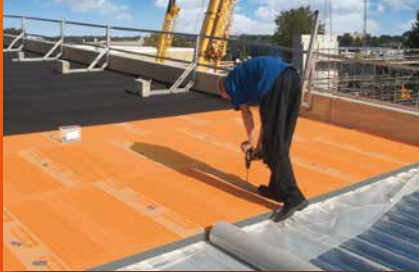
plat dak isolatie
