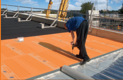
plat dak isolatie
