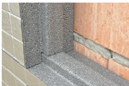
Messing/groef aansluiting voor een aaneengesloten isolatieschil.
