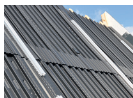
Geventileerde dakisolatie door de schubvormige waterkering.
