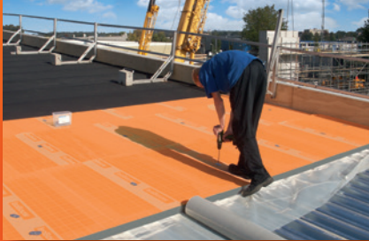
plat dak isolatie
