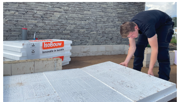
Eco-vloerplaat: voor een groot deel bestaande uit gerecyclede EPS
