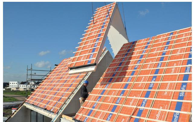
Op maat leveringen zorgen voor materiaalbesparing en beperking reststukken
