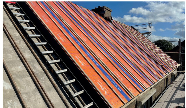
SlimFix Reno Twin : na-isolatie met handhaving van de bestaande onderconstructie
