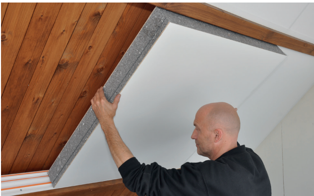
SlimFix Deco: demontabele isolatie voor het na-isoleren / opknappen van de zolder
