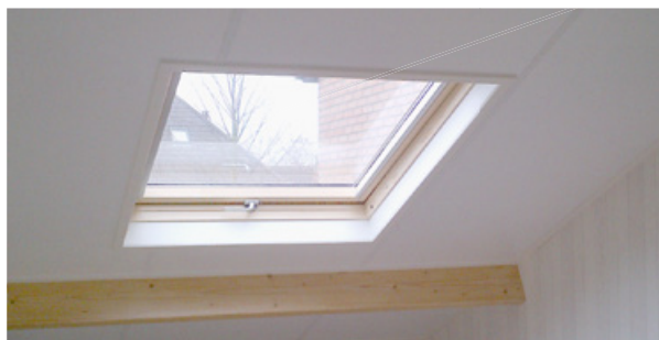
Geen ravelingen > een mooie esthetische binnenaafwerking
