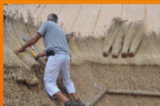
SlimFix XT Riet voor rietdaken (nieuwbouw/renovatie)
