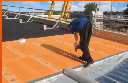
plat dak isolatie
